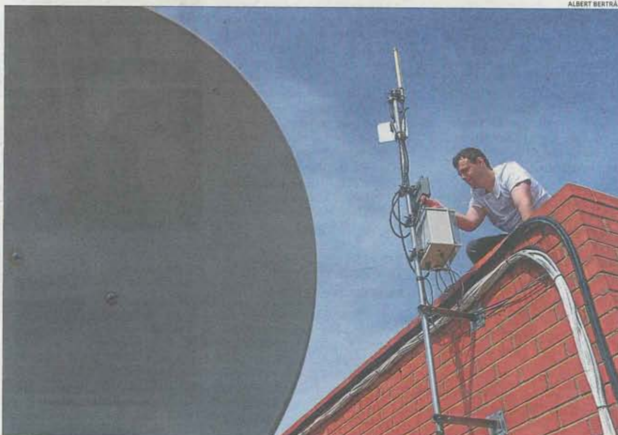
EDIFICIO ALTO. Un miembro de la organización monta un nodo en un tejado de Badalona, para que los vecinos accedan a la red.
